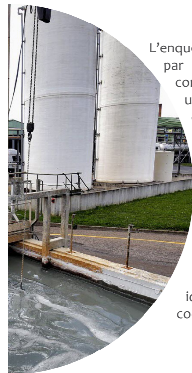
Le 5 mars dernier, visite du site de traitement des déchets chimiques d'Amnéville.
