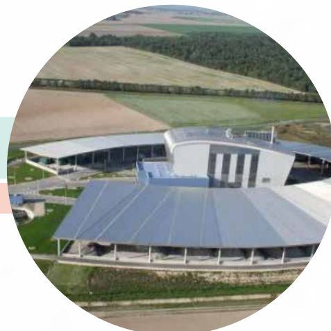
UVE de Châlons-en-Ch.
